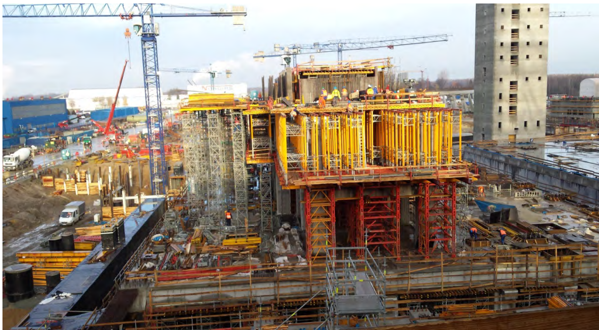
Rys. 15. Montaż podpór typu MULTIPROP płyty górnej turbozespołu
