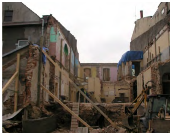
Rys. 8. Budynek nr 12 po wyburzeniu „wewnętrznej” konstrukcji
