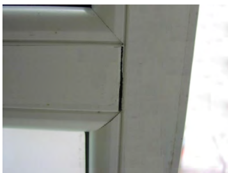
Fot. 1. a) Za krótka szczelina skrzydła drzwi - wcieka woda i wwiewane jest zimne powietrze; b) Rozminięte zaczepy – skrzydło samoczynnie się otwiera
