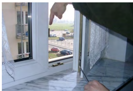
Fot. 1. a) Za krótka szczelina skrzydła drzwi - wcieka woda i wwiewane jest zimne powietrze; b) Rozminięte zaczepy – skrzydło samoczynnie się otwiera
