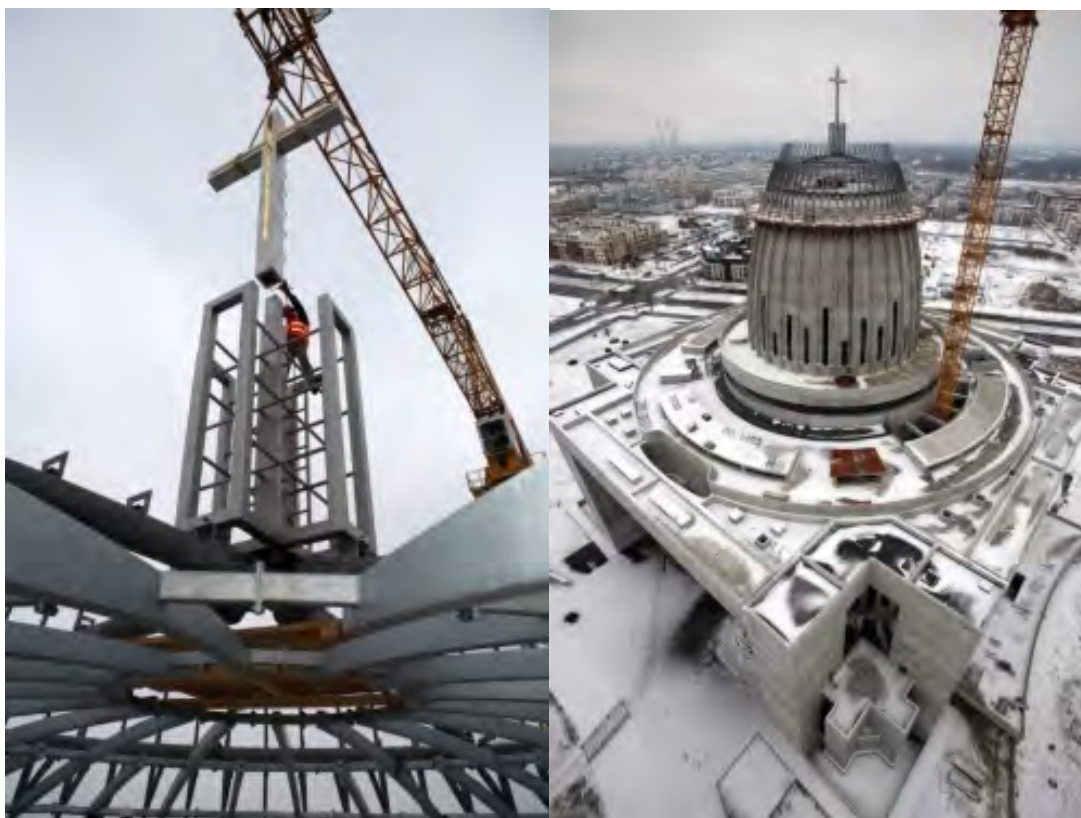
Il. 12. Montaż Krzyża na konstrukcji stalowej świetlika, fot. Warbud
