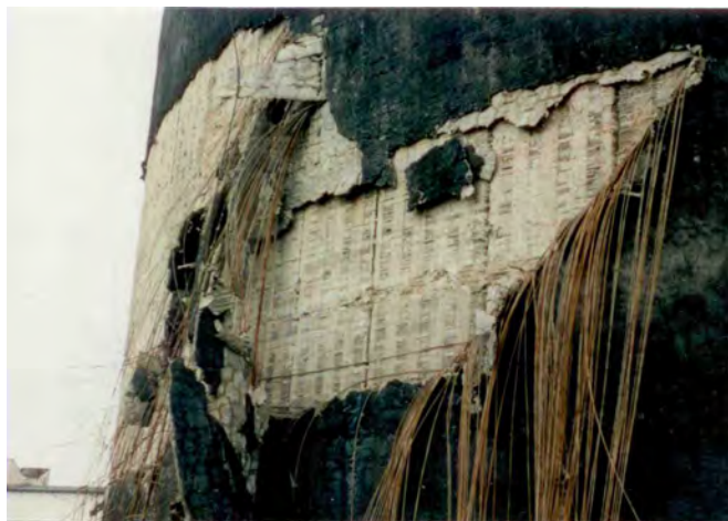
Rys. 4. Stan płaszcza silosu A: a) widok strun i zakotwień w odkrywcę płaszcza silosu poza strefą awarii, b) widok awarii strun sprężających od strony południowo-wschodniej
