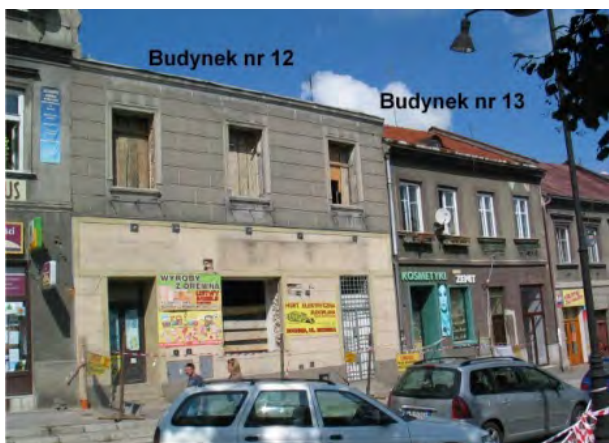
Rys. 7. Widok ogólny budynku nr 12 i nr 13 od strony frontowej
