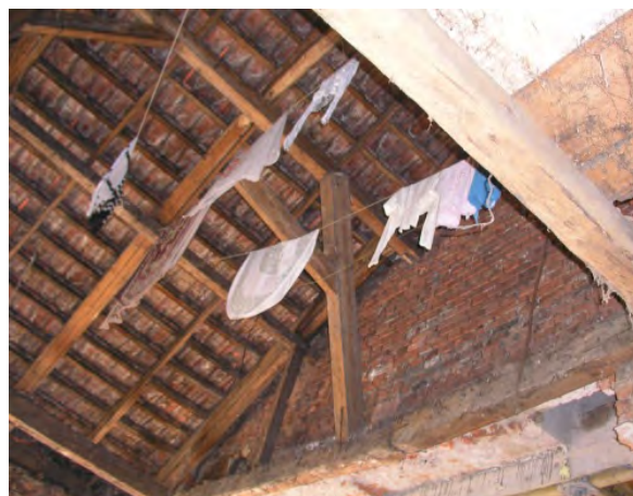
Rys. 12. Słupek podpierający płatew pośrednią - został wypchnięty
