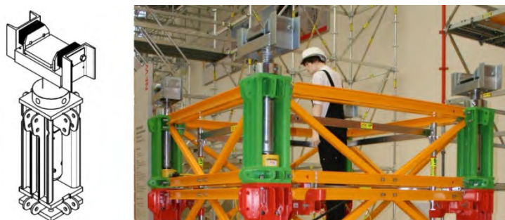
Rys. 7. Głowica VST 100. Na zdjęciu widoczne są siłowniki hydrauliczne zamontowane w głowicach
