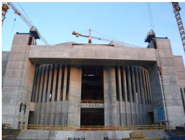
II.11. Faza podnoszenia, przed oparciem na pylonach
