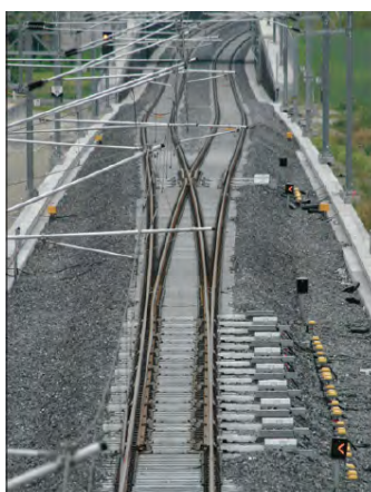
Rys. 1. Rozjazd łukowy symetryczny dużych prędkości, eksploatowany z prędkością 200km/h, posiadający 11 napędów w tym 8 zwrotnicowych i 3 w strefie krzyżownicy z ruchomym dziobem.
