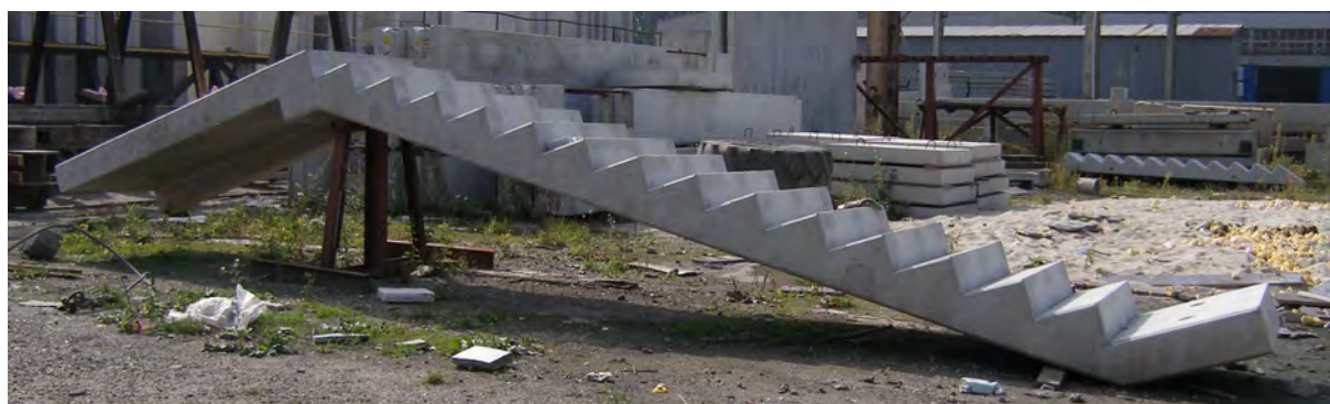
Rys. 9. Prefabrykowany segment schodów płytowych przewidzianych jako wejście na trybuny stadionu.
