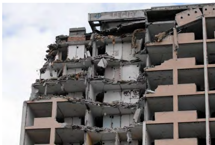
Rys. 2. Rozbiórka wielkopłytowego budynku hotelu robotniczego FSO /ul. Kowalczyka, Białoleka/
