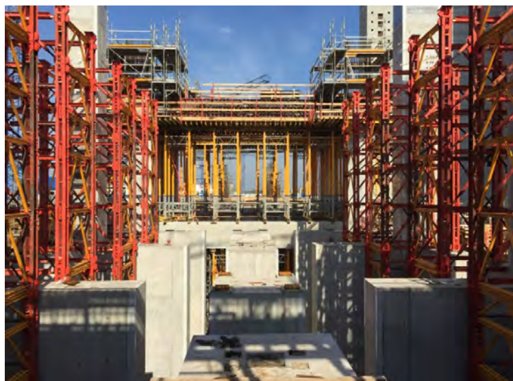
Rys 10. Rozpoczęcie montażu wież VST dla turbozespołu w Opolu
