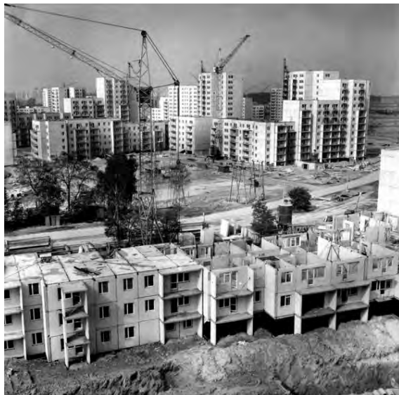
Rys. 1. Proces wznoszenia budynków wielkopłytowych osiedla mieszkaniowego w Nowej Hucie w latach 60-tych
