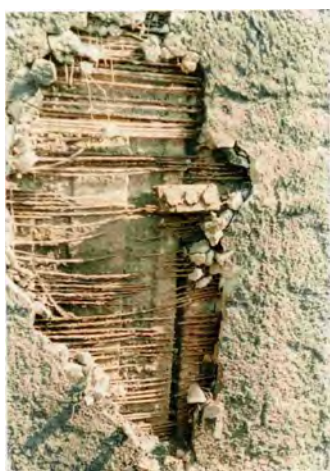
Rys. 4. Stan płaszcza silosu A: a) widok strun i zakotwień w odkrywcę płaszcza silosu poza strefą awarii, b) widok awarii strun sprężających od strony południowo-wschodniej
