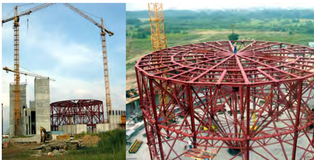
II. 3. Stalowa konstrukcja wsporcza o szkieletie prętowym z pomostem roboczym na poziomie +20,00 m i dwiema systemowymi kłatkami schodowymi [8]
